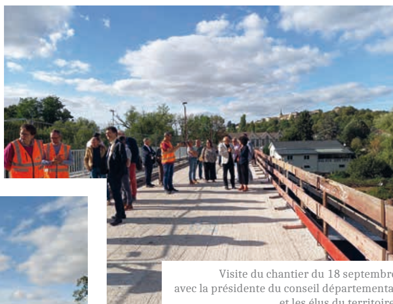
Coffrage et ferrailage du massif contrepoids côté Frouard fin août.
