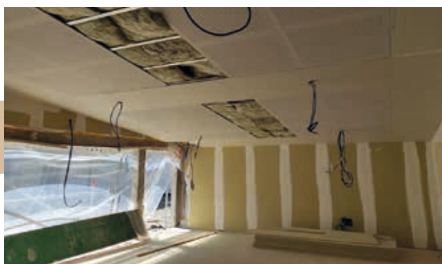
Isolation intérieure Cloisons coupe-feu, ossatures et plafonds acoustiques
