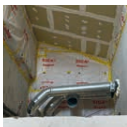
Chauffage Pose des conduits de ventilation
