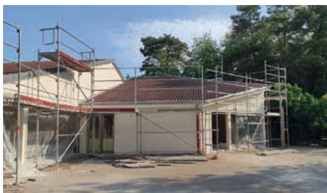
Ravalement de façade Peinture des murs extérieurs
