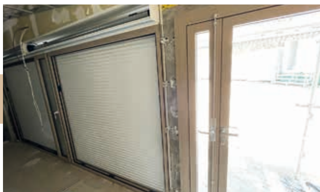
Menuiserie Pose des nouvelles fenêtres
