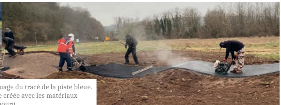
En direct du chantier. A gauche : Le marquage du tracé de la piste bleue. A droite : L'enrobé vient recouvrir la piste créée avec les matériaux concassés issus de la démolition de Lerebourg.
