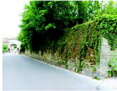
Le mur en pierres, rue Porte Haute
