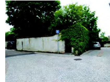
Le mur de clôture, Rue du Levant
