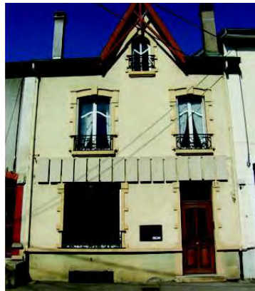
27 rue de la Gare AB 179 excepté le bandeau en béton
