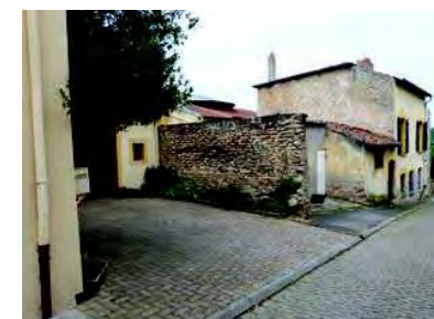
Le mur de clôture, Rue du Couchant
