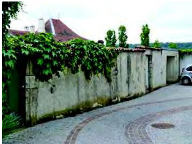
Le mur de clôture, Rue du Beaujour
