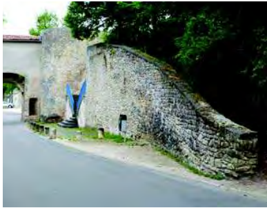
Le mur en pierres, rue Porte Haute
