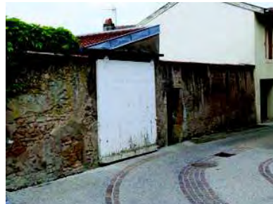
Le mur de clôture, Rue du Couchant
