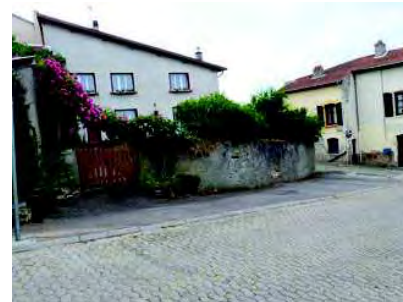
Le mur de clôture, Grande Rue
