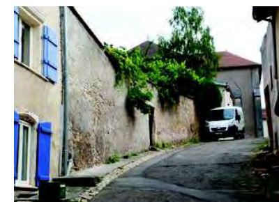
Le mur de clôture, Rue du Couchant
