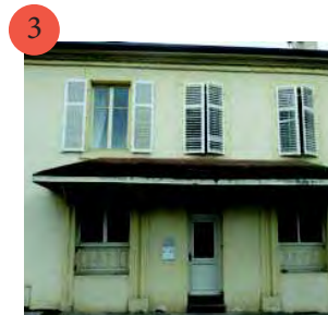
3 Construction de bourg. Corniche du début du 20 ème siècle. Auvent ajouté dénaturant la façade.
