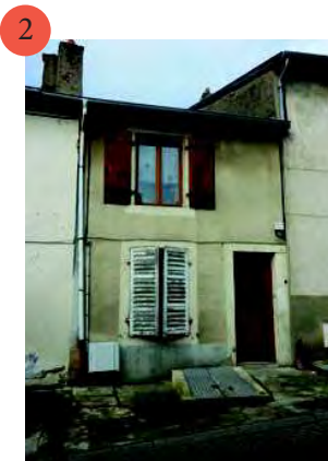
2 Construction rurale, avec une trappe de cave.
