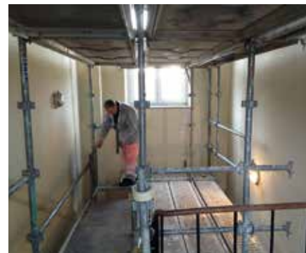
Travailler en hauteur dans des espaces exigües.
